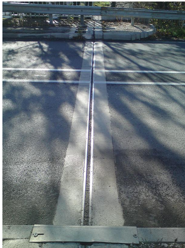
Imagen 5: Juntas de dilatación de un puente. Fuente: Wikipedia . Autor: Licencia: Creative Commons (CC)
